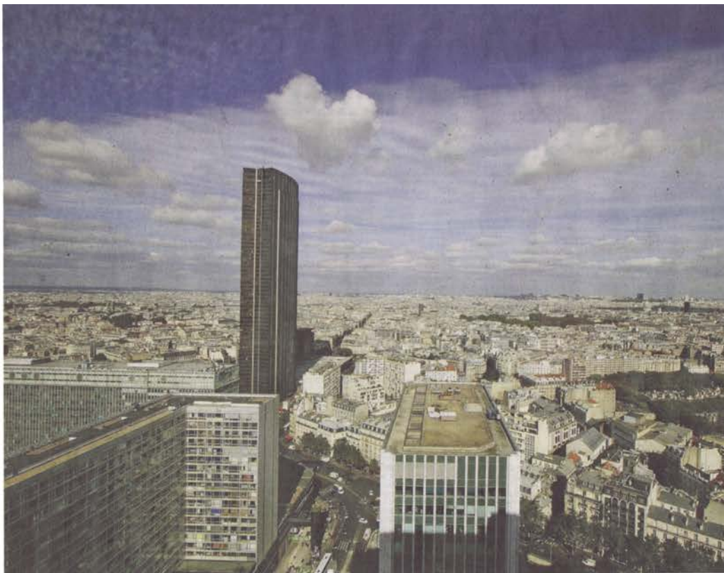
Située dans le XV e arrondissement de Paris, la tour Montparnasse a été inaugurée en 1973. À cette époque, l'amiante était utilisé pour servir de coupe-feu et d'isolant. JEAN-CLAUDE
